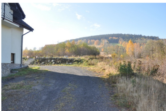
km 0+288,50 koniec odbudowy odcinka ul. Wodnej
