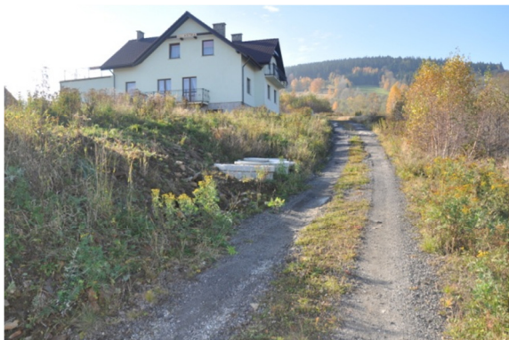
km 0+243,35 istniejące studnie kanalizacji sanitarnej
