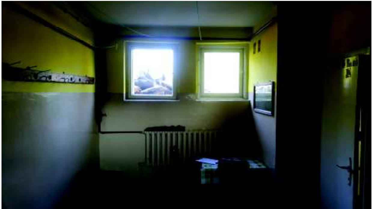
FOT. 9 POMIESZCZENIA SZATNIOWE
