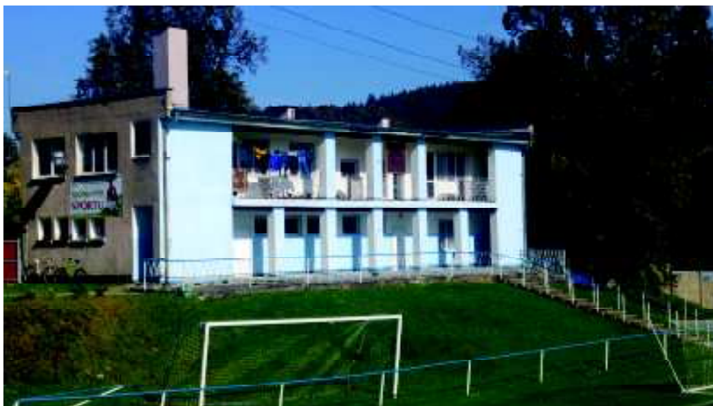
FOT. 1 WIDOK ELEWACJI FRONTOWEJ I BOCZNEJ
