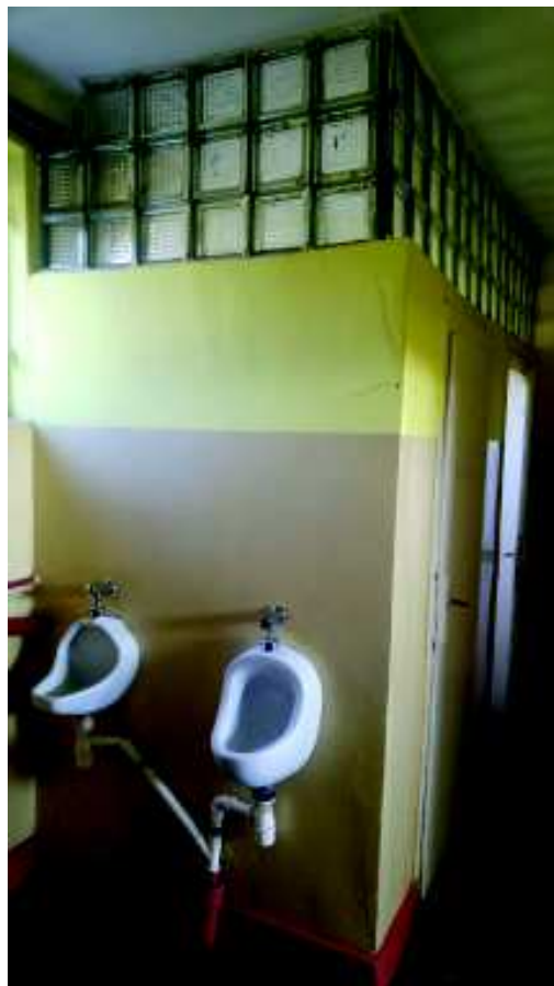
FOT. 10 POMIESZCZENIA HIGIENICZNO SANITARNE
