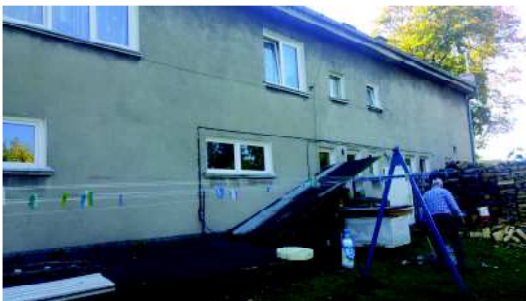
FOT. 2 WIDOK ELEWACJI TYLNEJ - PÓŁNOCNEJ
