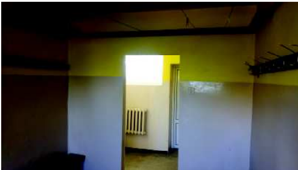
FOT. 8 POMIESZCZENIA SZATNIOWE
