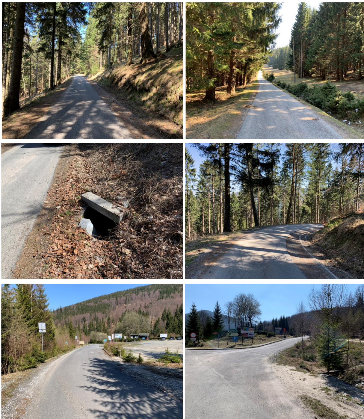
Km 0+3000 koniec odcinka Kletno
