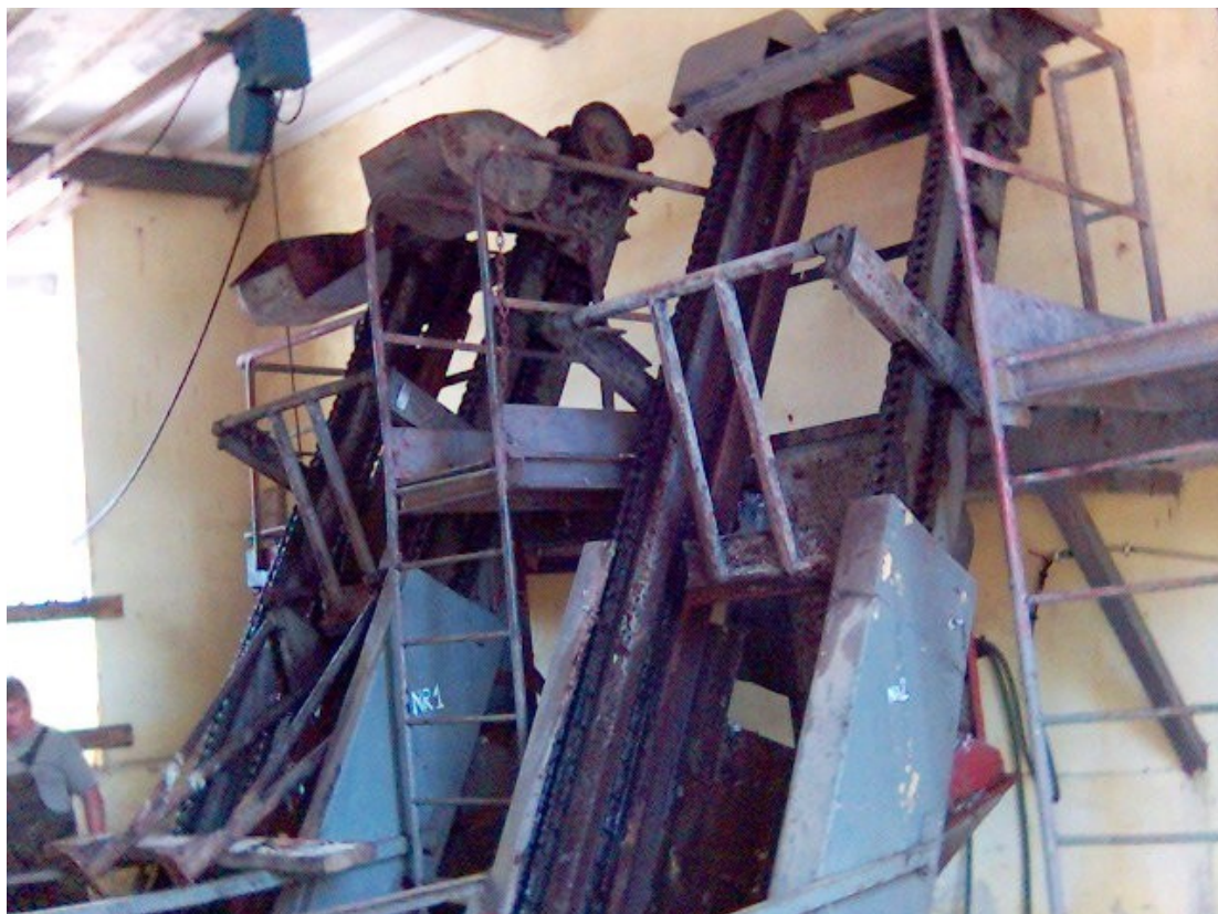
a) krata płaska, mechaniczna
