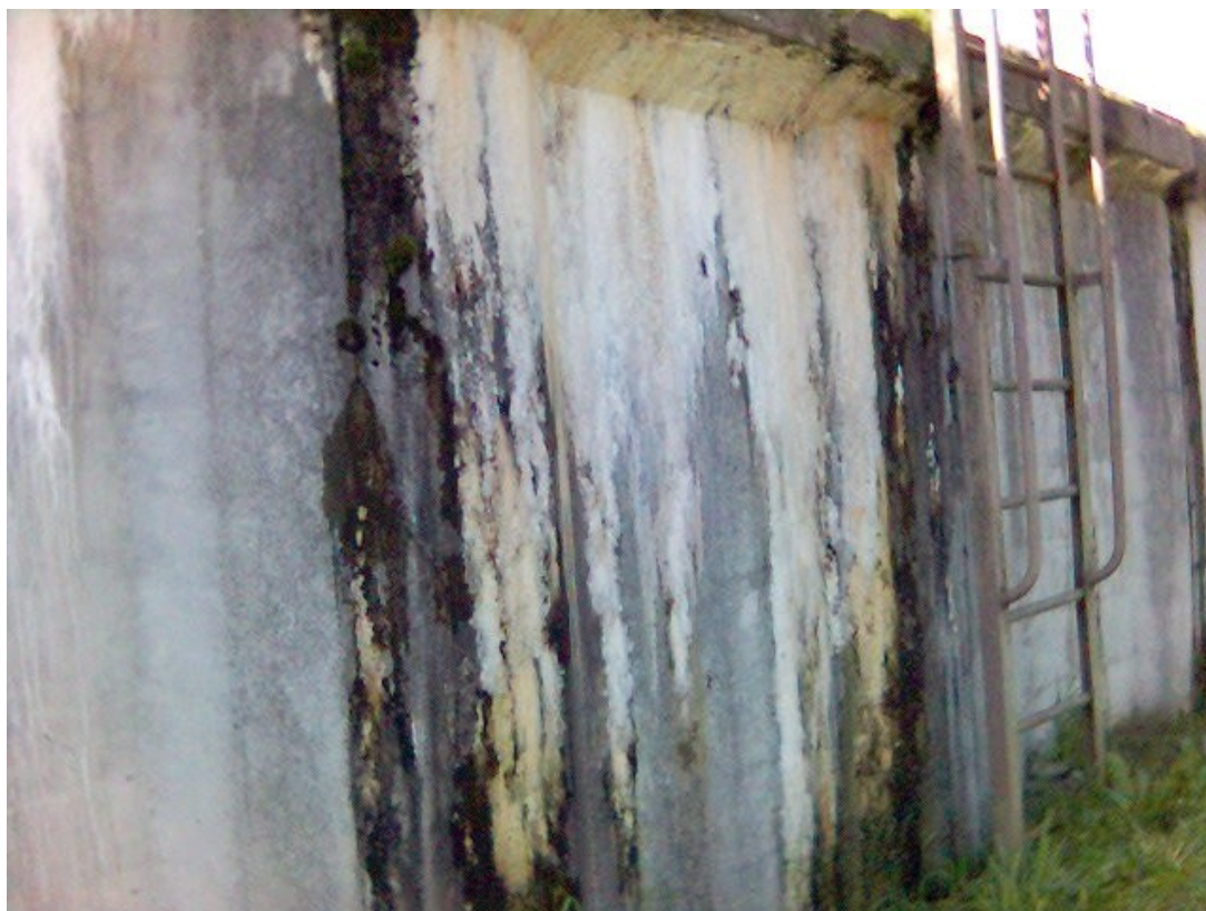
b) ściana zewnętrzna reaktora biologicznego
