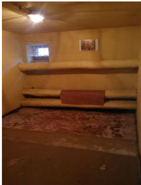
piwnice - pomieszczenie piwniczne
