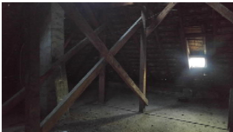
wieżba dachowa płatwiowo-kleszczowa - widoczne stężenia więzby - zastrzały i miecze
