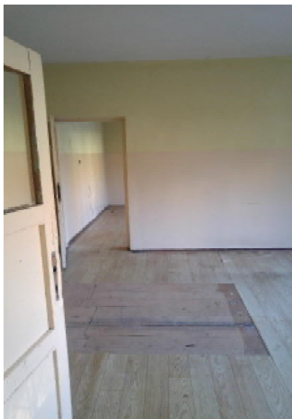
kondygnacja mieszkalna - pomieszczenia
