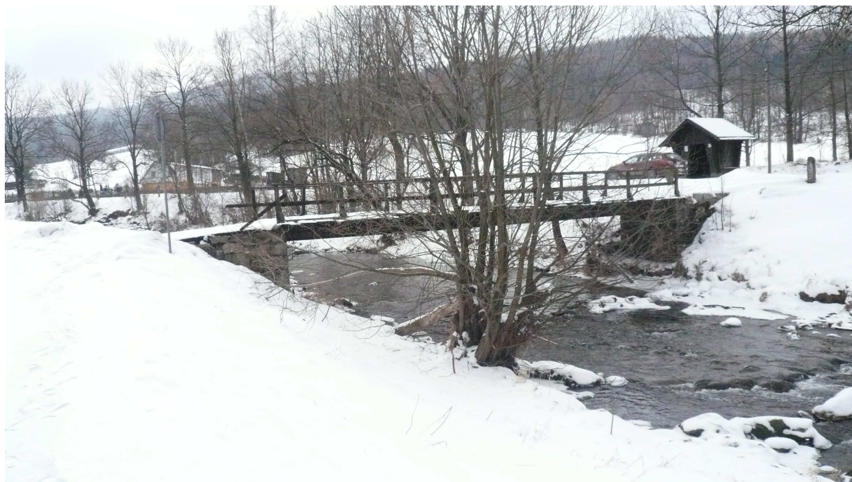
Fot. 2 - widok z drogi gminnej od strony dolnej wody
