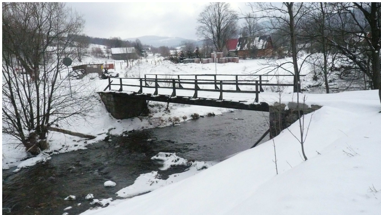
Fot. 1 - widok od strony drogi dojazdowej powiatowej nr 45106 od strony dolnej wody.
