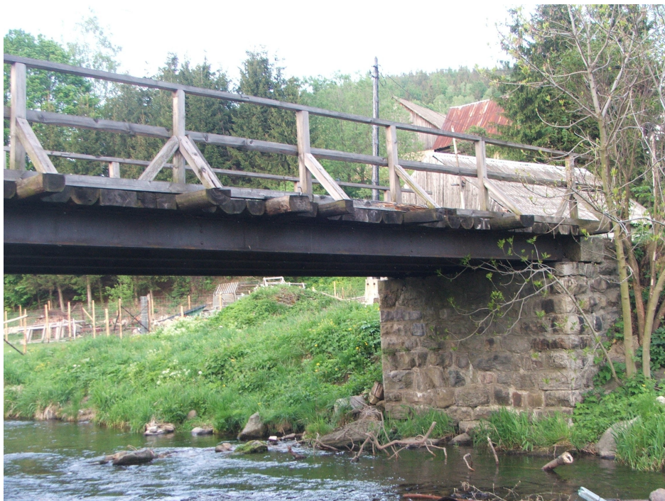
Fot. 1 i 2 - widok od strony dolnej wody.
