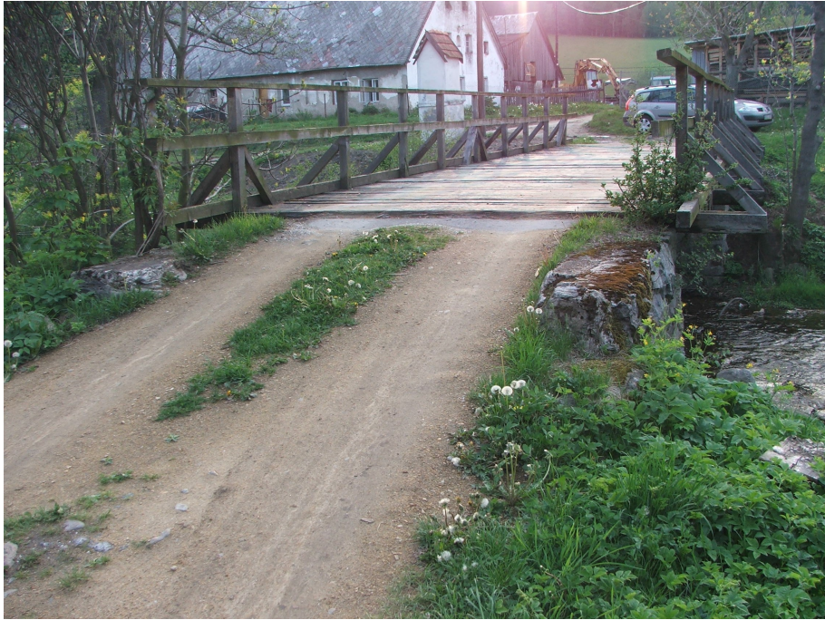
Fot. 3. dojazd do mostu od strony bud. nr 2.
