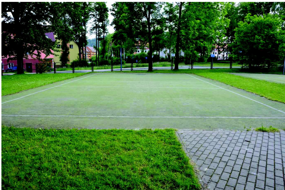
Widok istniejącego boiska do siatkówki – do remontu.
