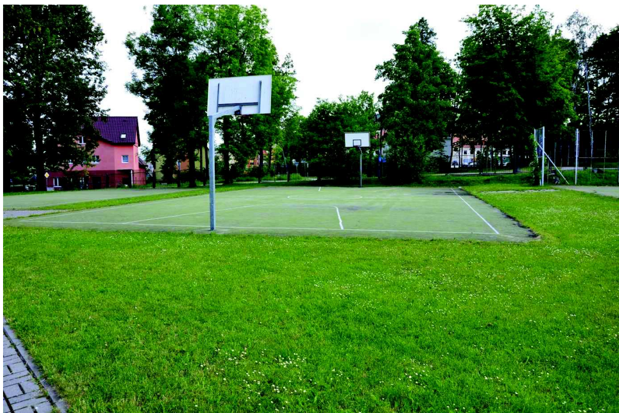
Widok istniejącego boiska do koszykówki – do remontu.
