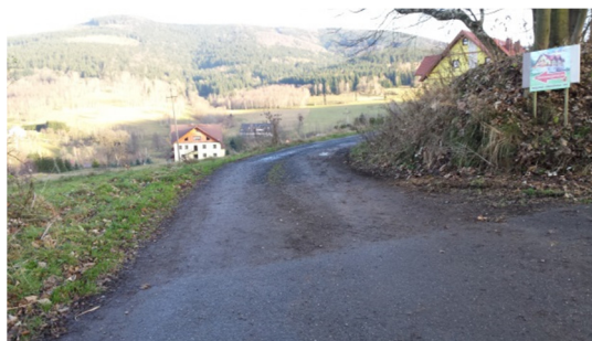
Km 0+315,27 koniec przebudowywanego odcinka drogi
