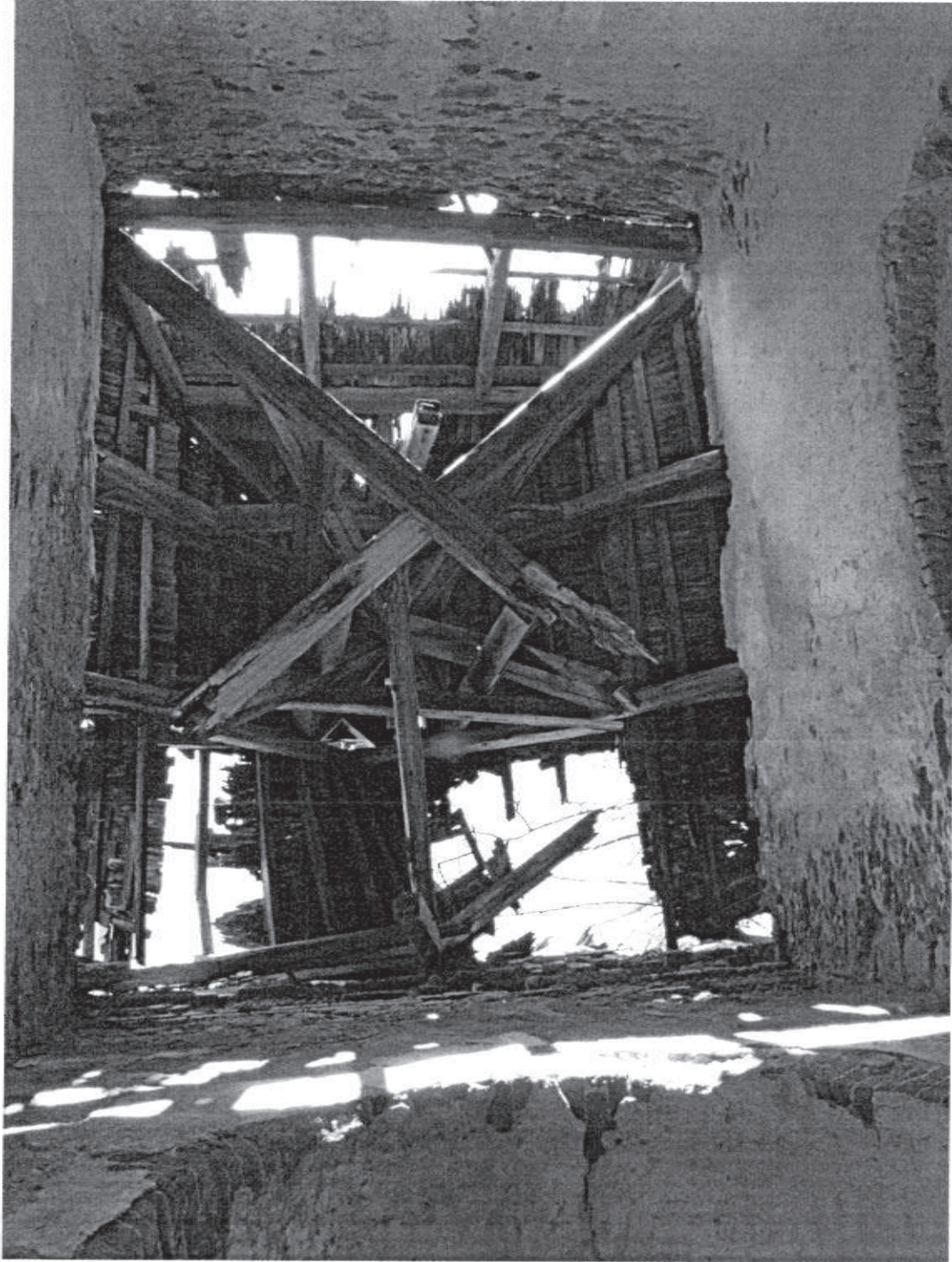
FOT. NR 6 WIDOK NA KONSTRUKCJĘ ZADASZENIA PREZBITERIUM Z SYGNATURĄ
