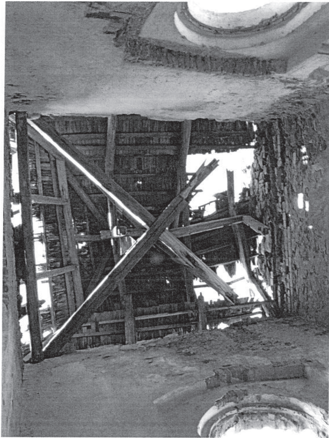
FOT. NR 5 WIDOK NA KONSTRUKCJĘ ZADASZENIA PREZBITERIUM Z SYGNATURĄ
