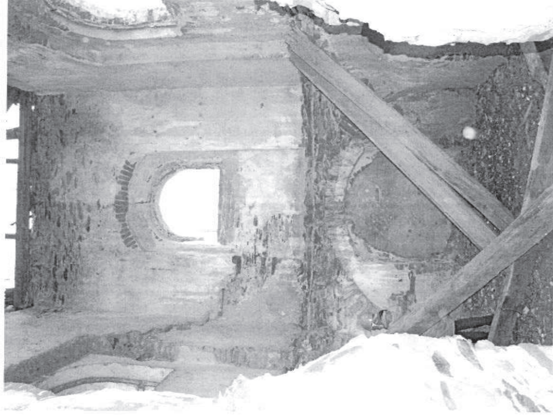
FOT. NR 8 WIDOK NA WNETRZE PREZBITERIUM
