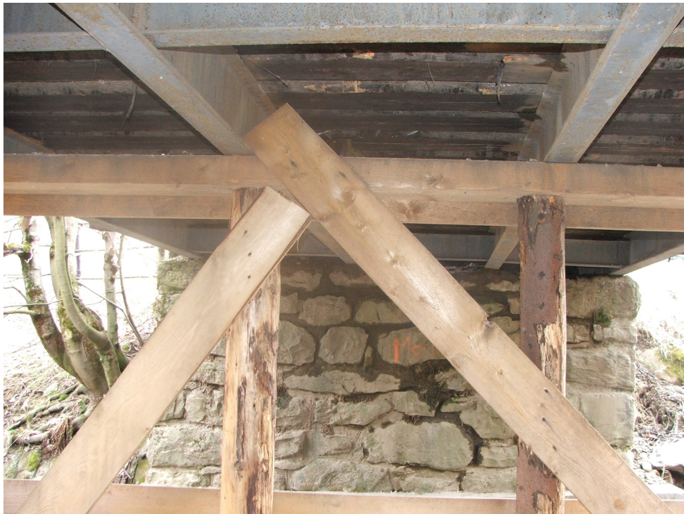
Fot. 3. widok od spodu mostu.
