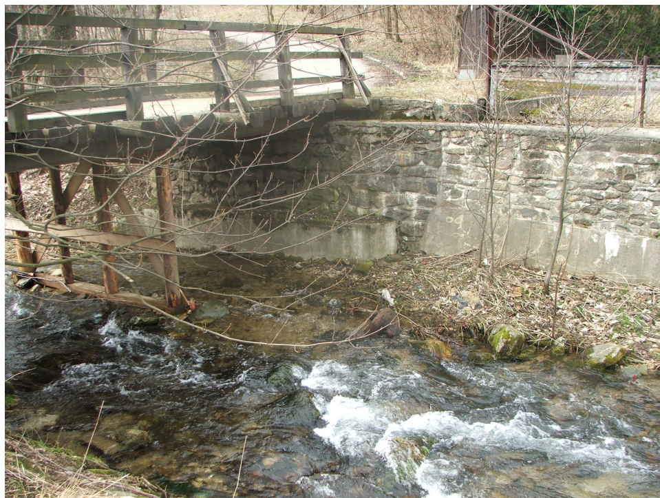
Fot. 4. widok od strony dolnej wody.
