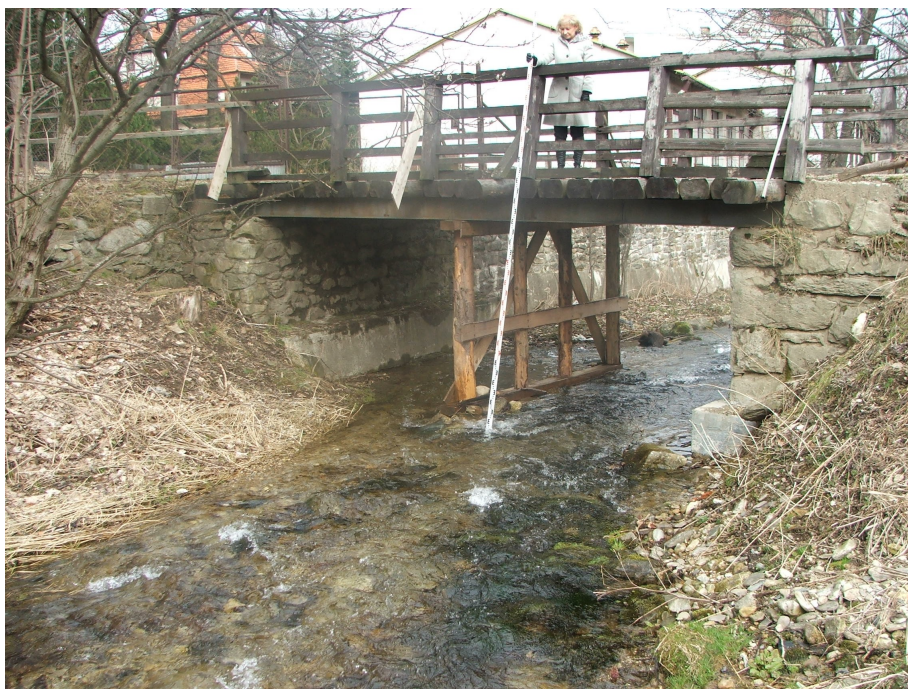
Fot. 2 - widok od strony górnej wody.
