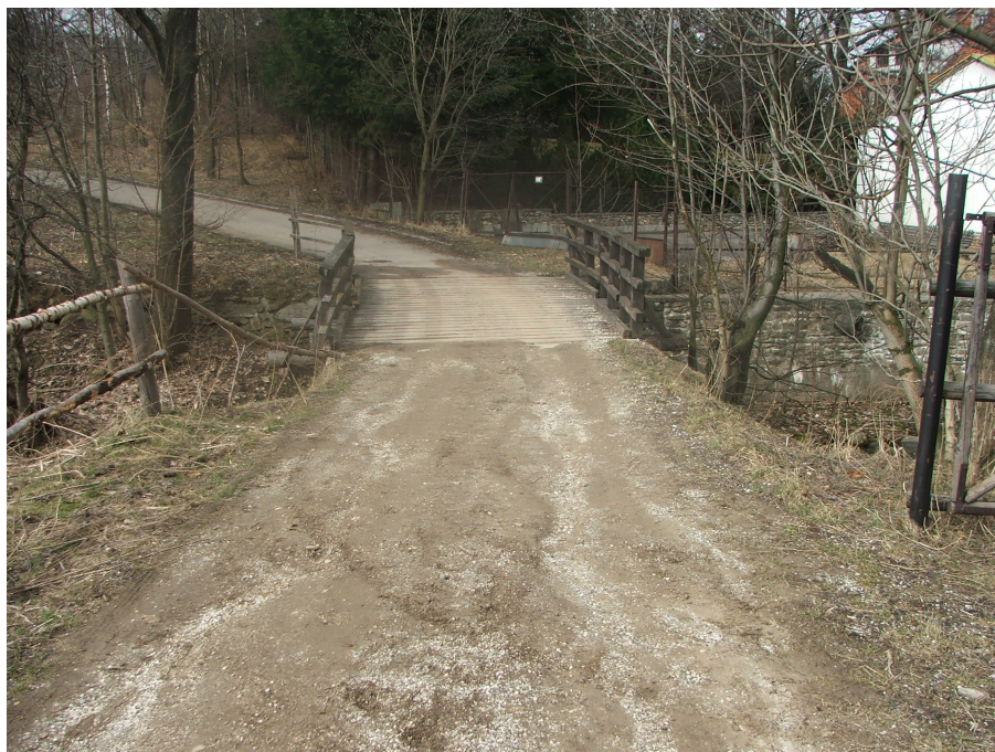
Fot. 1 - widok od strony drogi dojazdowej gruntowej.
