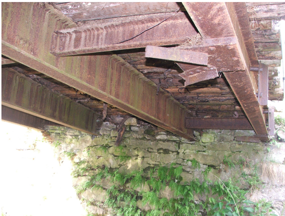
Fot. 4. widok od spodu mostu.
