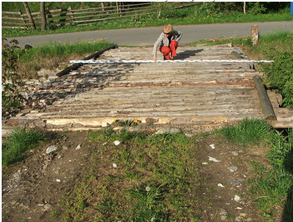
Fot. 3. widok płyty pomostowej z bali drewnianych.
