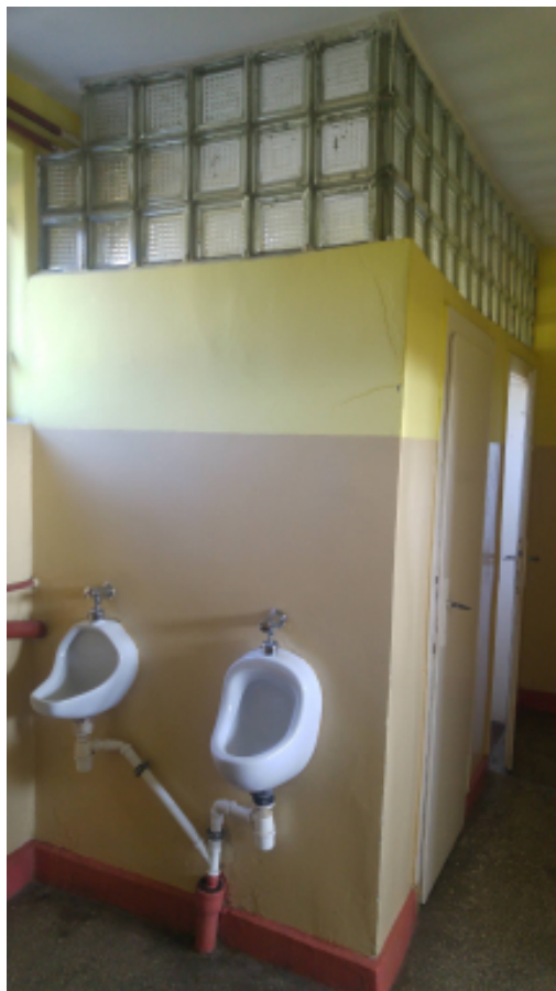
FOT. 10 POMIESZCZENIA HIGIENICZNO SANITARNE
