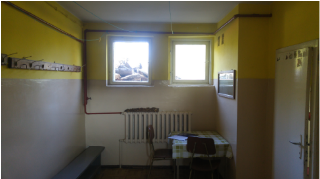
FOT. 9 POMIESZCZENIA SZATNIOWE
