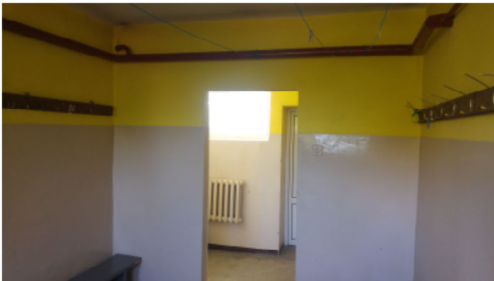
FOT. 8 POMIESZCZENIA SZATNIOWE
