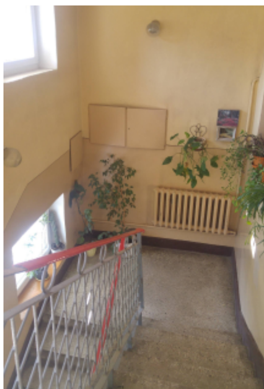
FOT. 12 KLATKA SCHODOWA
