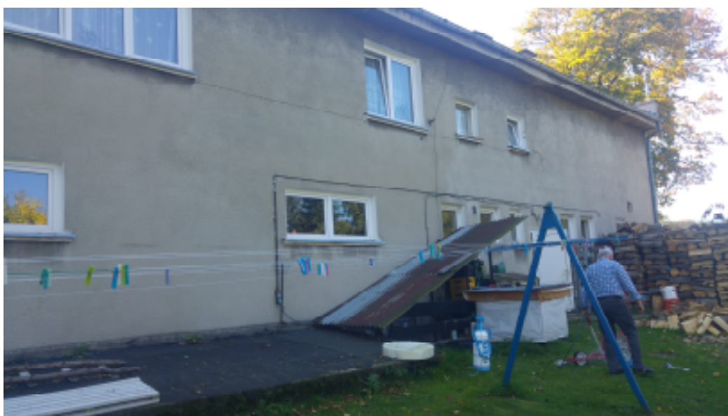
FOT. 2 WIDOK ELEWACJI TYLNEJ - PÓŁNOCNEJ
