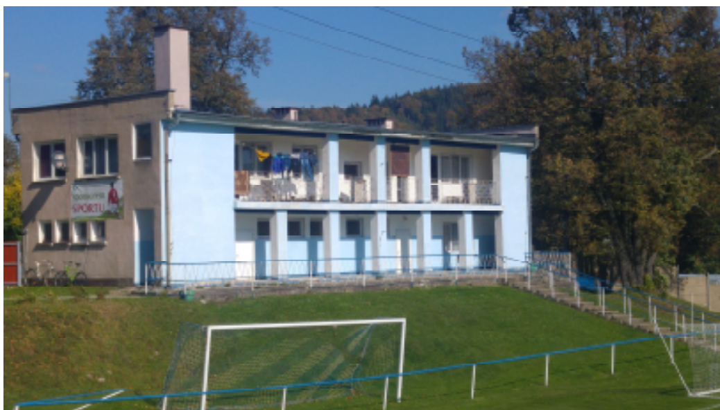
FOT. 1 WIDOK ELEWACJI FRONTOWEJ I BOCZNEJ
