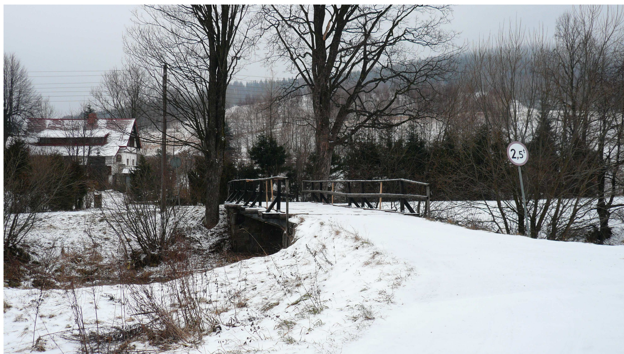
Fot. 1 - widok od strony drogi dojazdowej powiatowej nr 45106.
