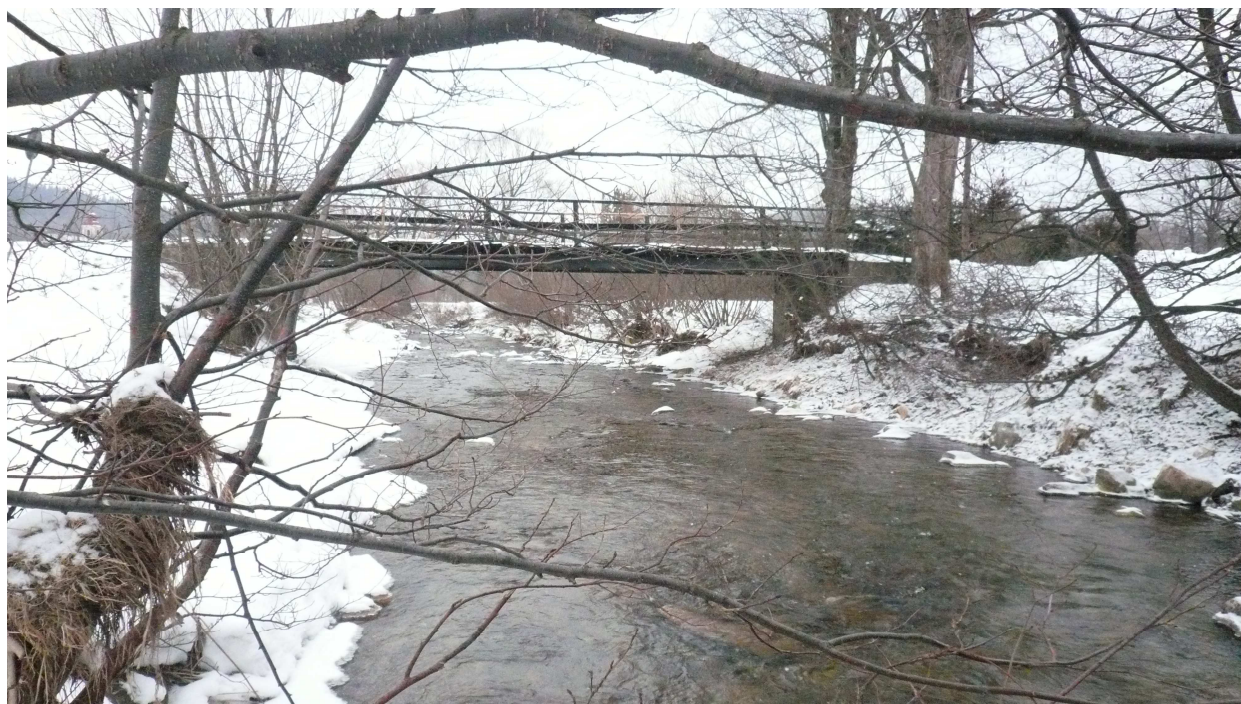
Fot. 3 - widok od strony górnej wody.
