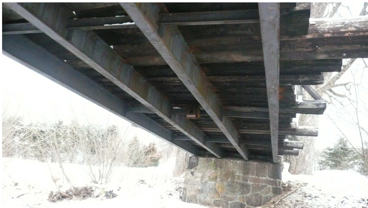
Fot. 4. widok od spodu mostu.
