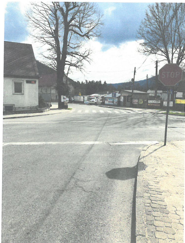
widok przejścia dla pieszych od wjazdu na skrzyżowanie z ulicy Kościuszki
