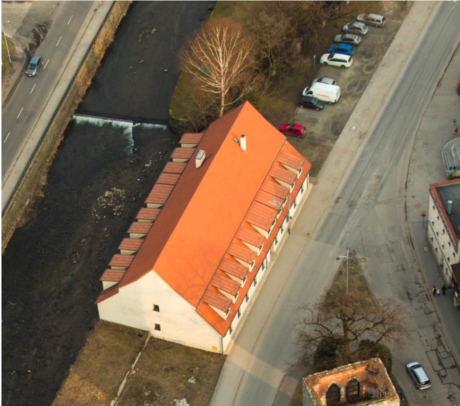
Fot. 2 Zabytkowa słodownia położona bezpośrednio nad korytem rzeki
