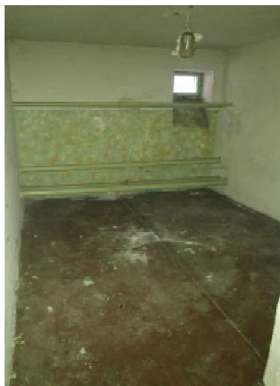
piwnice - pomieszczenie piwniczne
